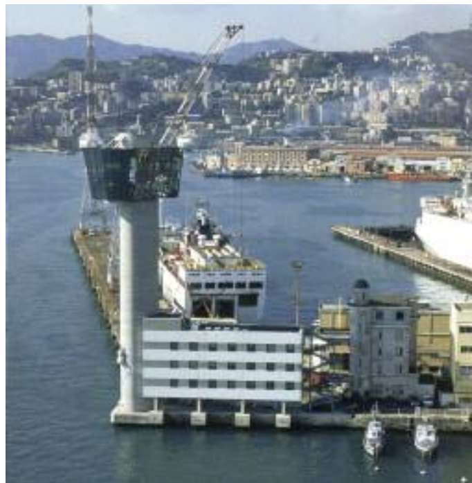
La torre piloti entrata in funzione il 1977
