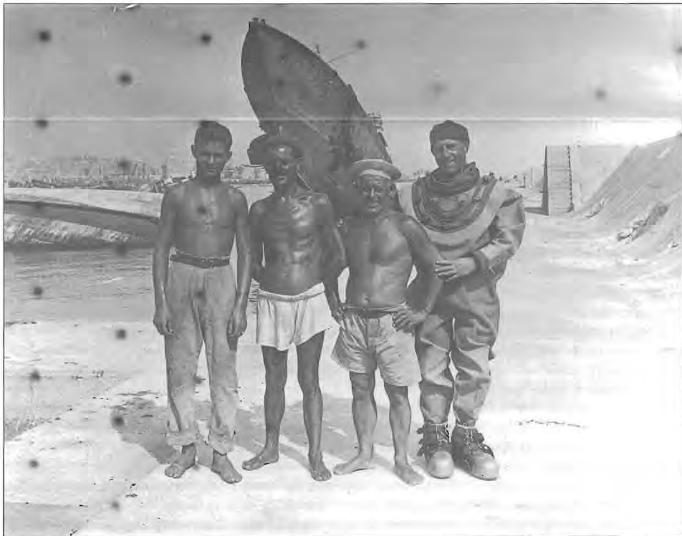
Agosto 1945. Diga Foranea. Palombaro e la sua squadra impegnati nel recupero dei relitti affondati dalle truppe tedesche per rendere inagibile il porto di Genova. La squadra era composta dal palombaro, dalla guida e da due marinai addetti alla pompa dell'aria. La foto, realizzata dal socio Casali, era in origine su vetrino.
